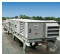
Belüftung: Wärmerückgewinnung
