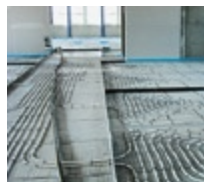
Fußbodenheizung: passiv kühlen
